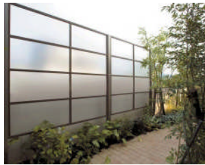
ポリカのパネルを使用しているため、光も取り入れられる。
